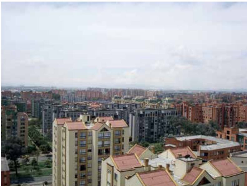
COLECCIÓN PARTICULAR SEBASTIÁN PUERTA GIRALDO VISTA DEL EDIFICIO CORPORATE CENTER PISO 11 ALTURA: 36,17 M AV. EL DORADO # 69 B-53 - CIUDAD SALITRE FOTOGRAFÍA DIGITAL
